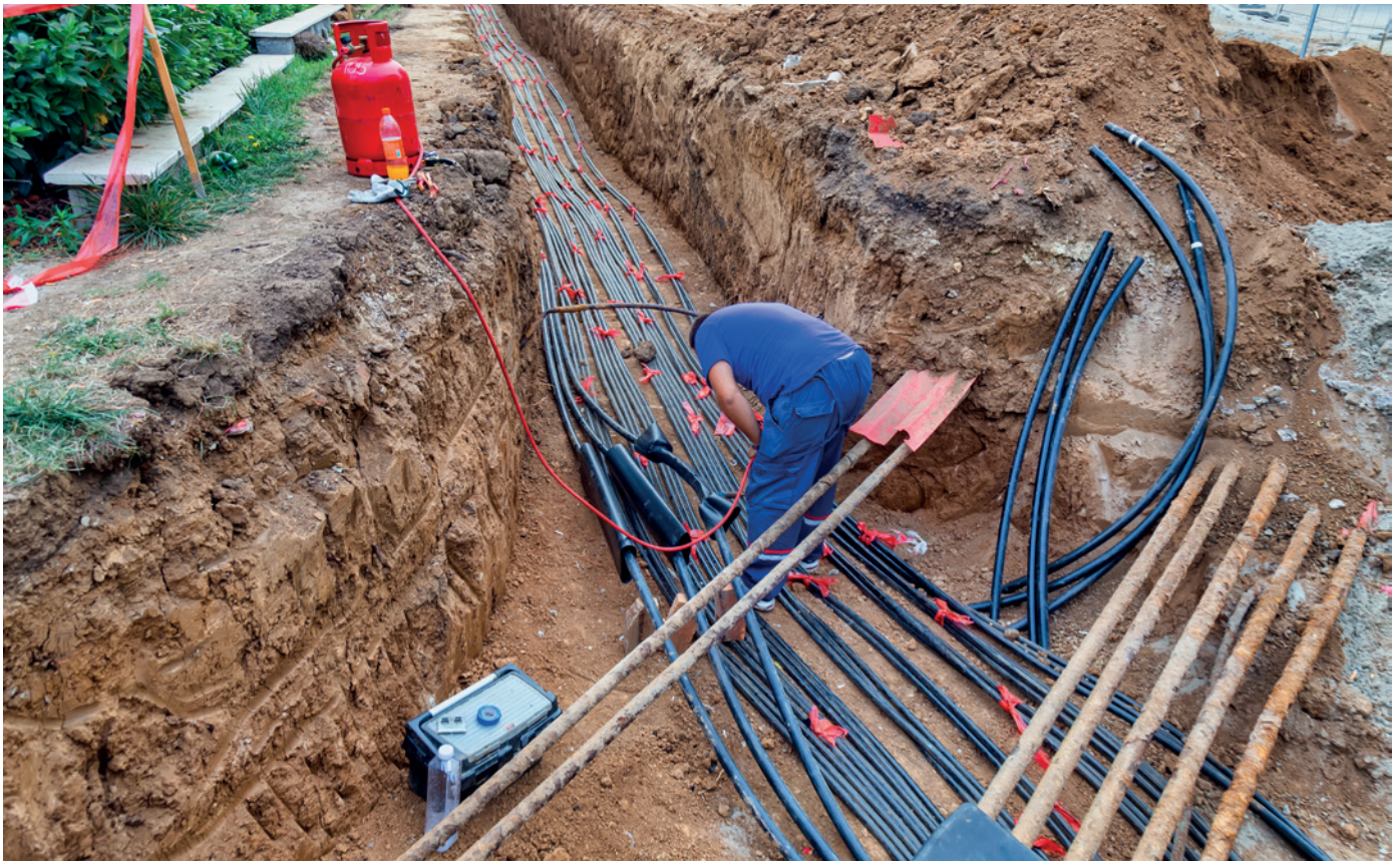
Zunehmend unübersichtlich: Auch im Rahmen der Energiewende müssen immer mehr Leitungen im Straßenprofil neu verlegt werden.
