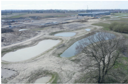
Blick von oben auf das Regenwassermanagementsystem aus Becken, Teichen und Kanälen
