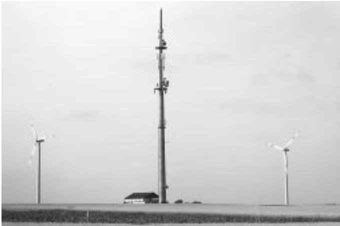
Abb. 5: Freistehende Mobilfunkanlage in Nachbarschaft zu Windenergieanlagen
