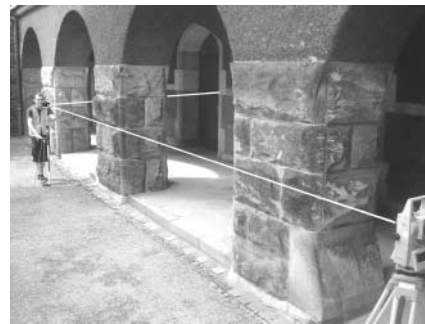
Abb. 6: Aufnahme des Schumannbaus
