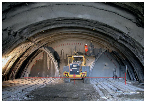
Abb. 7b | Messtechnische Unterstützung der NÖT, Absteckung eines Rohrschirms /Amberg Technologies/
