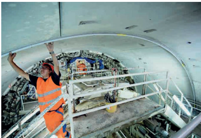
Abb. 17 | Konvergenzmessungen mit dem System tShape nach Tübbingebau /Terravermessung/
