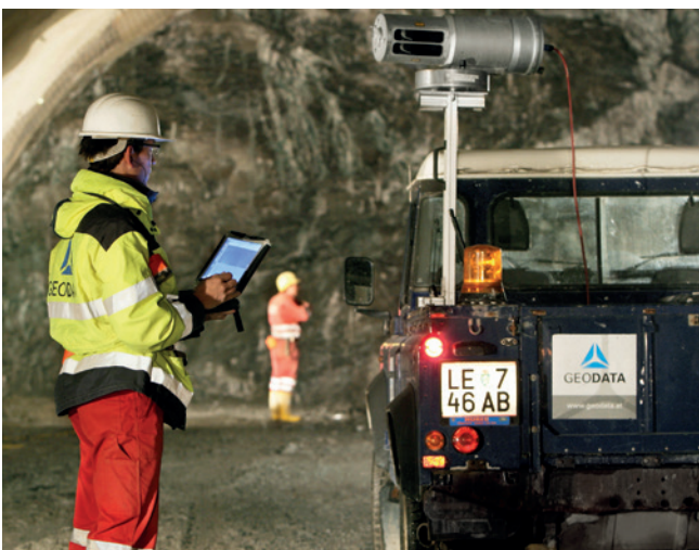
Abb. 18 | Profilkontrolle mit Tachymeter und fahrzeuggestütztem 3D-Laserscannersystem /Geodata/
