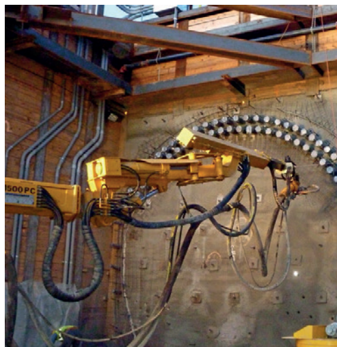
Abb. 8 | Herstellung Rohrschirm über der Tunnelanschlagwand /Dywidag/
