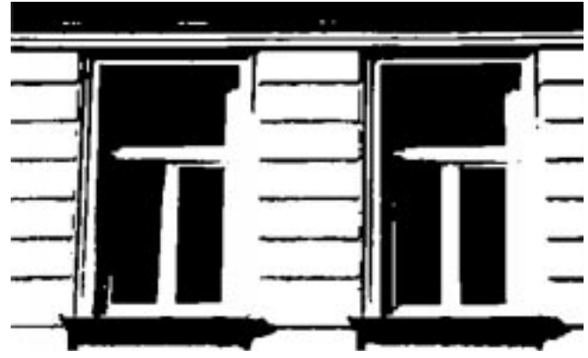
Abb. 6: Originalbild nach Histogrammstreckung, Schwellwertoperator und Median-Filter (3 x 3)
