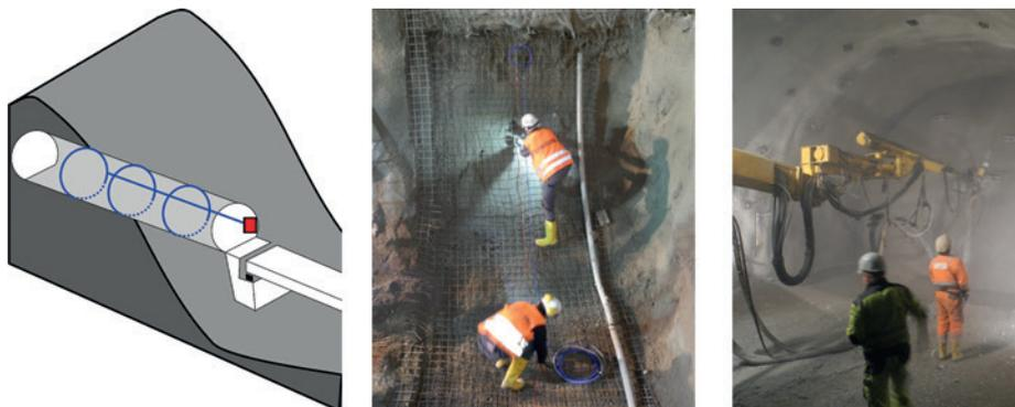
Abb. 4 | Konzept von verteilter faseroptischer Dehnungsmessung im Tunnelbau (links), Montage von Sensorkabel (Mitte), Spritzvorgang (rechts)
