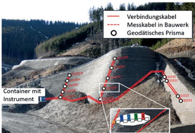
Abb. 9 | Kombinierte geodätische und faseroptische Überwachung einer BEK (links), Dehnungsverlauf in den ersten Monaten von vier Bereichen in Ebene 2 von Profil 2 (rechts)
