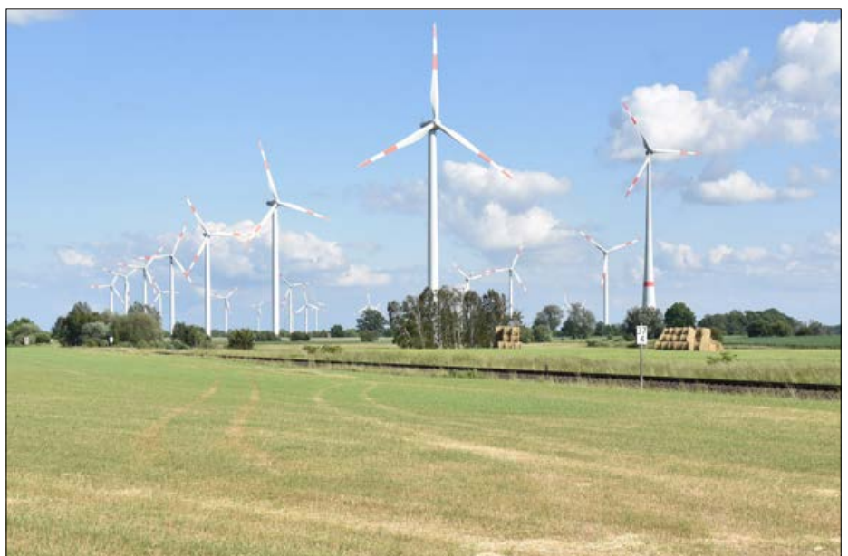
Abbildung 1: Veranschaulichung der abnehmenden Entfernungswirkung (Foto: Caroline Fischer 2021)
