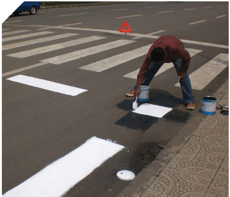
Signalisieren eines der 62 Passpunkte vor dem Bildflug. // Marking one of 62 ground control points prior to aerial photography.
