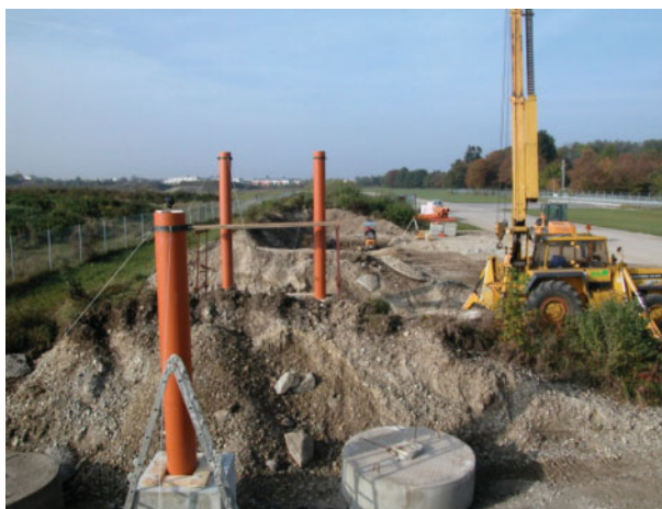
Abb. 7 | Absteckung der Pfeiler
