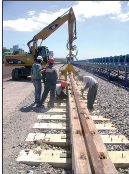
**Bild 8: Aufbau der Stacker/Reclaimer und erste Nachstopfarbeiten am optimierten Schiene-Schwelle-System**
