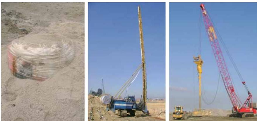
**Bild 7:** Herstellung der geotextilummantelten Sandsäulen (links), der Vertikaldräns (Mitte) und der Rüttelstopfsäulen (rechts)
