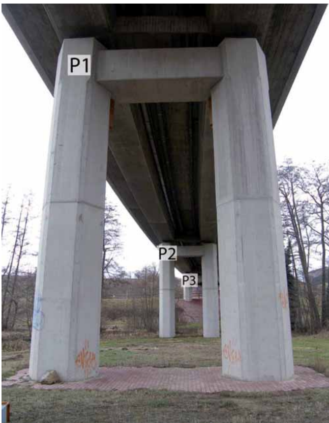
Abb. 10: Unterseite der beobachteten Brücke.
