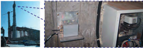
Abb. 6 | Anbindung der Beschleunigungsaufnehmer während der Bauzeit
