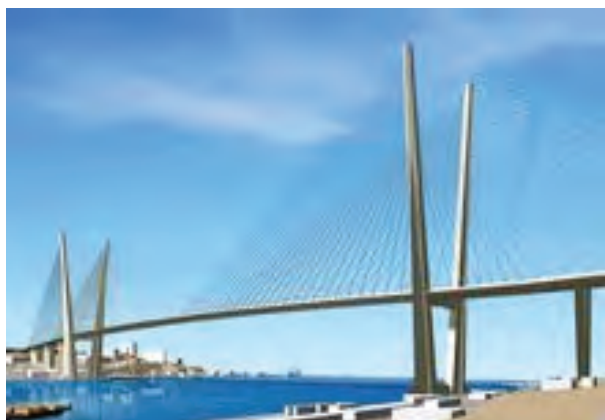
Abb. 1 | Brückenbauwerk über die Bucht „Goldenes Horn“
