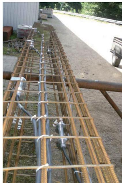
Abb. 2: Fixierung von Sensorträgern in einer Pfahlbewehrung (Foto: BAM, Rammpfahl-Herstellung: Centrum Pfähle GmbH Hamburg)
