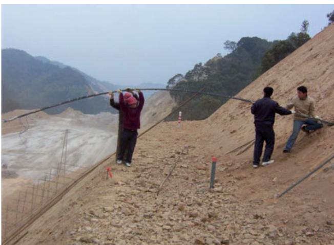
Abb. 4: Einbau eines faseroptischen Sensors in einen Hang für Permanent-Monitoring (Foto: Prof. Bin Shi, Nanjing Univ., China)
