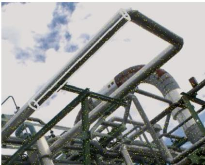
*Abb. 4: Extraktion von Zylindern aus der Punktwolke. Zur besseren Veranschaulichung ist die photogrammetrische Aufnahme unterlegt.*
