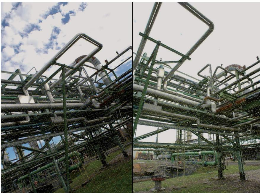
*Abb. 5: Registrierung von Punktwolken über Raumgeraden, links: Laserscan vom Standpunkt 1 mit vorgegebenen Zylinderachsen (helle Geraden), rechts: Laserscan vom Standpunkt 2 mit vorgegebenen Zylinderachsen (helle Geraden)*
