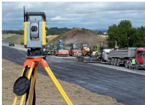
Abb. 5 | PCS900 Fertigersteuerung mit UTS Totalstation
