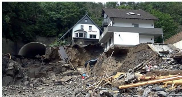
Abb. 9 | Situation an der Tunneleinfahrt mit Blick in Richtung Altenahr am 21. August 2021. Die „Straße“ im Vordergrund (Bild links) ist schon um mehrere Meter mit Erdschutt aufgefüllt, die Gebäude und Stützmauern sind gesichert /Bild: M. Petry/
