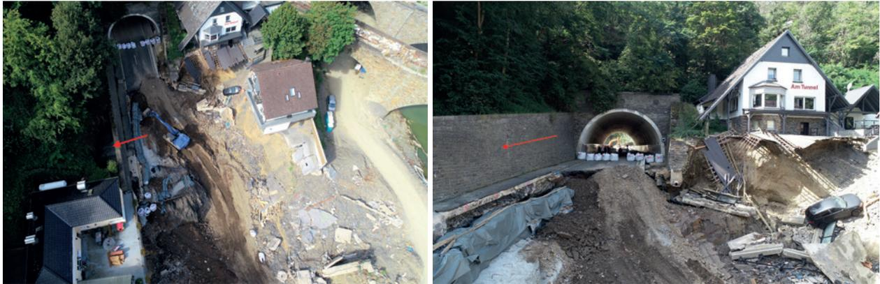
Abb. 10 | Zur Beachtung im linken Bild: die Stützmauer ist auf ca. 70 m hinter- und unterspült, was aus der Luftaufnahme ersichtlich wird /Bild: M. Petry/
