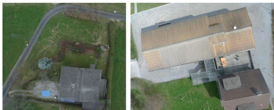
Abb. 1 | Links: UAV-Aufnahme vom Gebiet Krattigen; Rechts: UAV-Bild mit einem Ausschnitt des Gebietes Science City (ETH Zürich).
