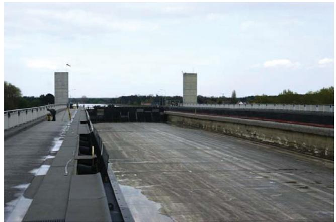
Abb. 1: Trogbrücke im entleerten Zustand
