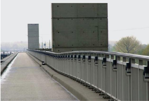
Abb. 9: Deutlich ist am Geländer die Aufwölbung der Brücke von max. 250 mm durch die fehlende Wasserlast zu erkennen
