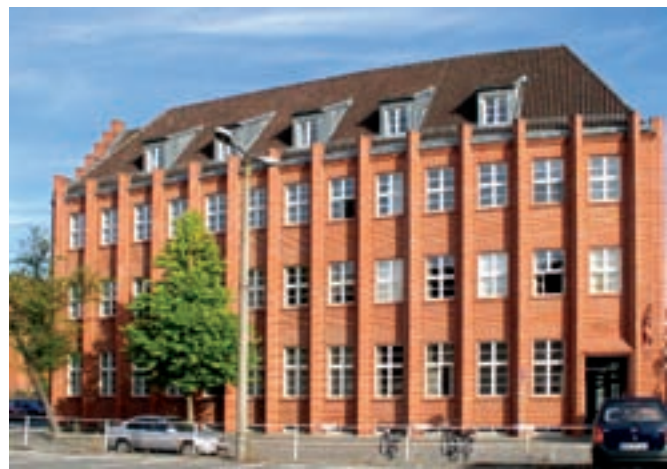
Ehemalige Neubauten (oben) abreißen oder sanieren? Diese Frage stellt man sich im Forster Rathaus (unten).
