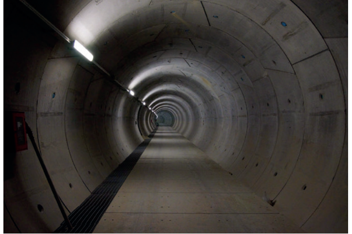
10,5 km langer Erkundungsstollen Aicha-Mauls
