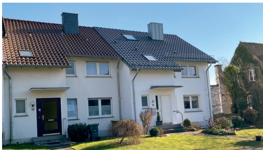
Abb. 12 | Visuelle Erfassung der Fassadendämmung durch die unterschiedliche Wandstärke bei gut vergleichbaren Objekten
