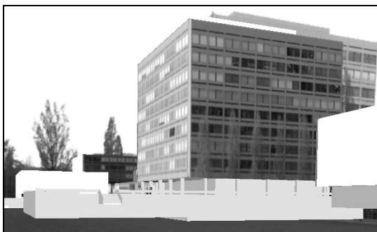
Abb. 6: AR-Szene des Campus Muttenz mit texturiertem Hauptgebäude und untexturierten Nebengebäuden, Blickrichtung nach Westen
