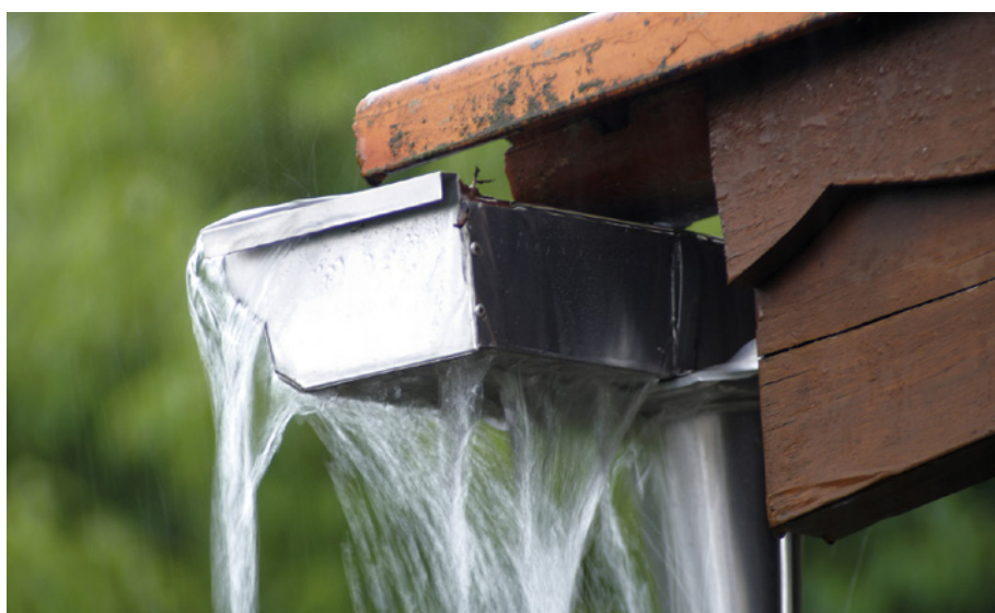
Kein Halten mehr: Dachrinnen und Fallrohre können langanhaltende und intensive Starkregen nicht abführen. Quelle: © Michel Fritzen – Fotolia.com.
