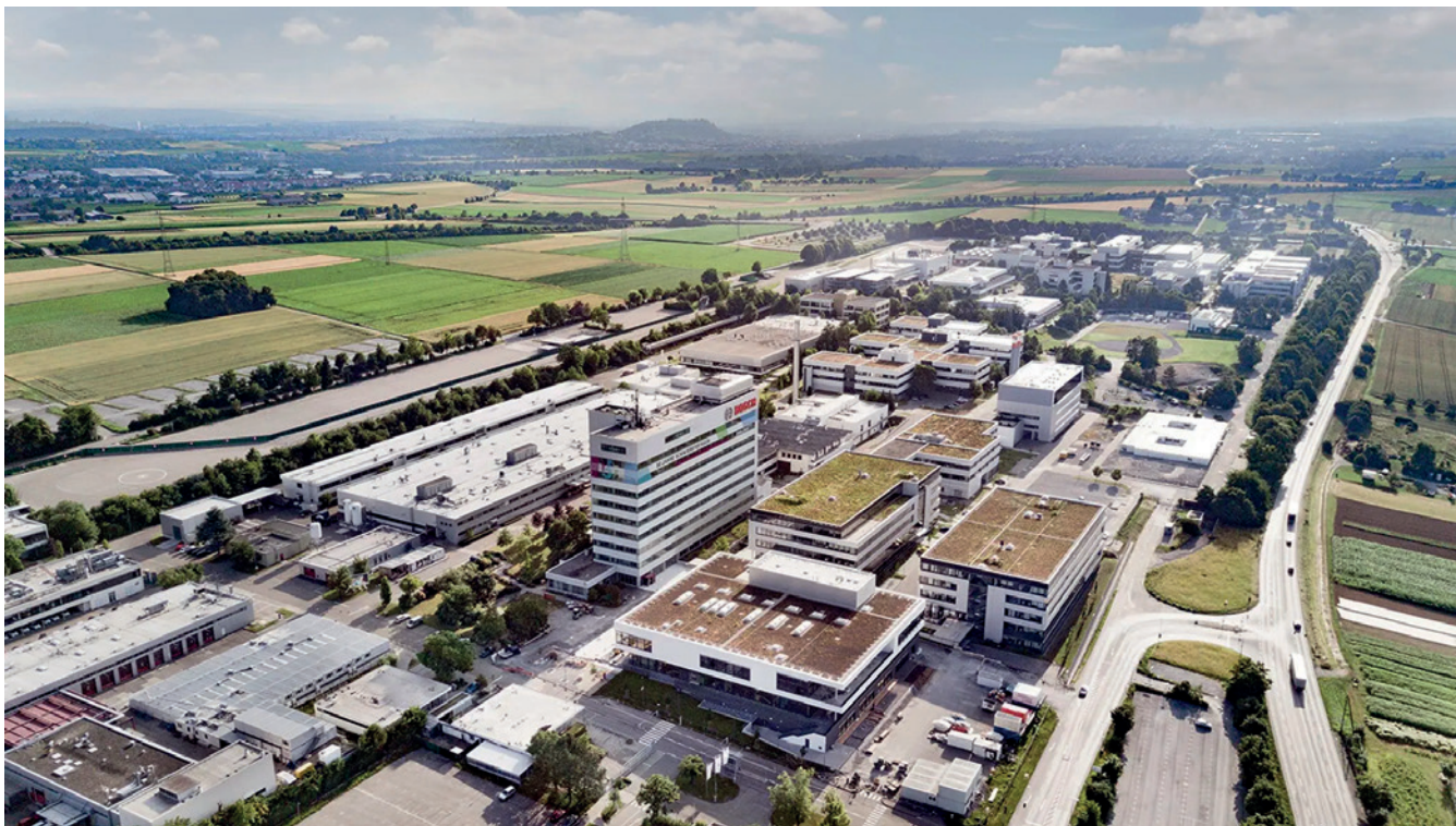
Am Industriestandort von Bosch in Schwieberdingen werden zukunftsweisende Energielösungen getestet
