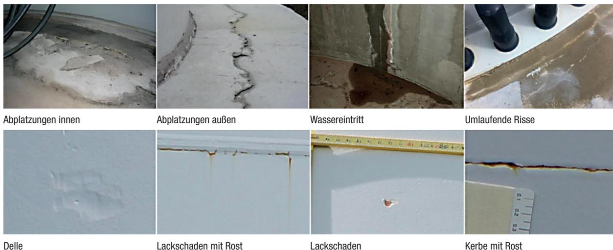
Abb. 1 | Typische äußere Defekte von tragenden WEA-Konstruktionen
